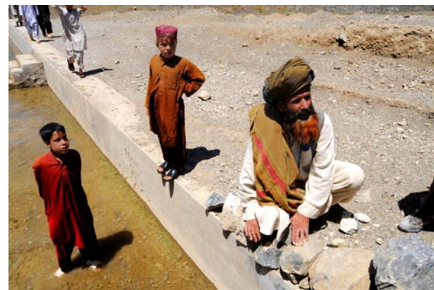
Afghánistán: Vodovod v obci Chinarey, Lógar
