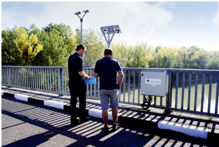
Moldavsko: Protipovodňová monitorovací stanice v povodí řeky Prut
