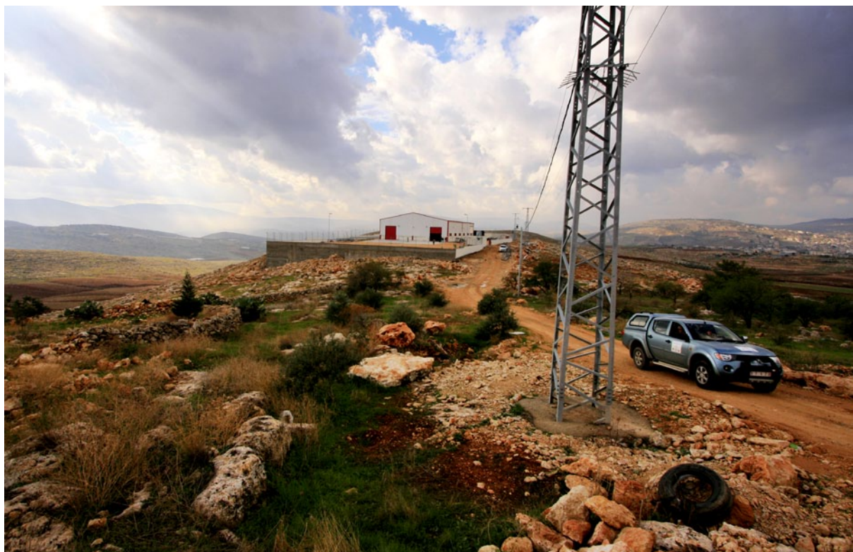
Palestina: Opravárenské středisko pro transformátory v Tubásu
