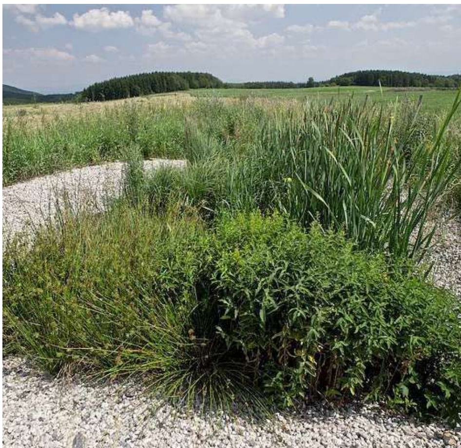
Kořenové čističky jsou ideálním technickým řešením pro čištění splaškových vod. Zájem o tuto technologii mají i některé balkánské země, například Bosna a Hercegovina. FOTO: KORENOVA-CISTICKA.CZ
