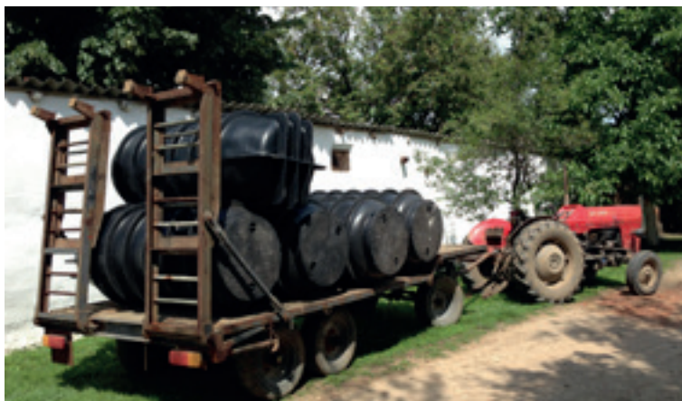
Srbsko: Výstavba kanalizační sítě v obci Kruščica
